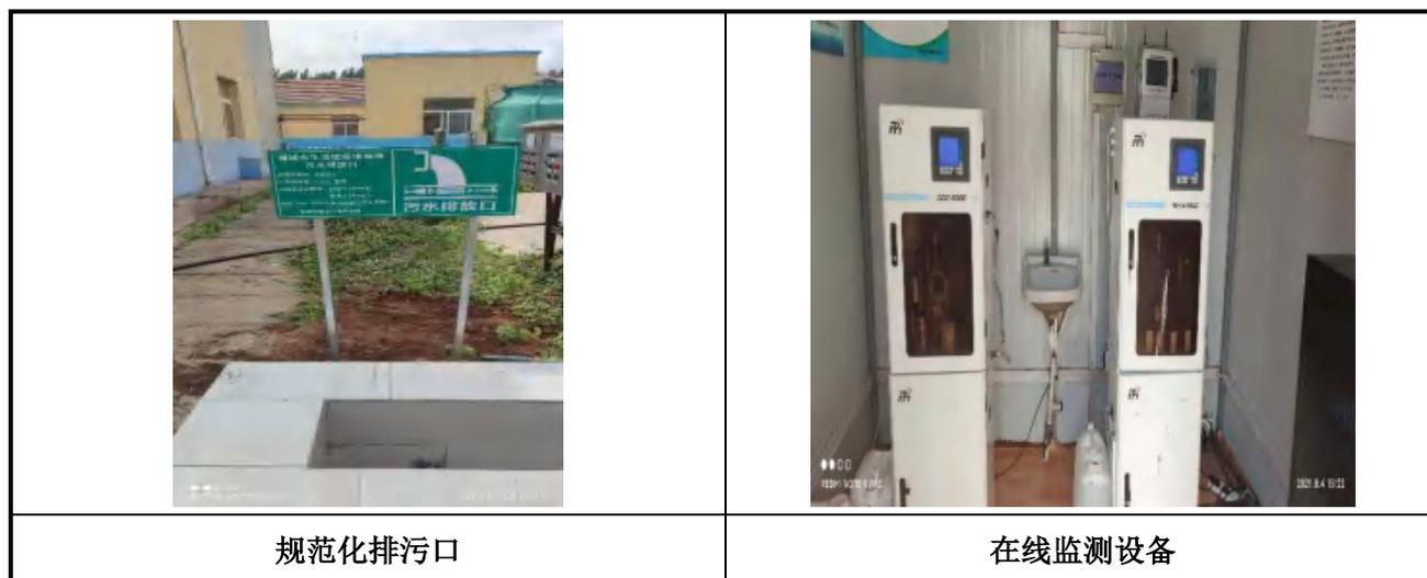
图 4-9 排污口规划化及在线监测照片
